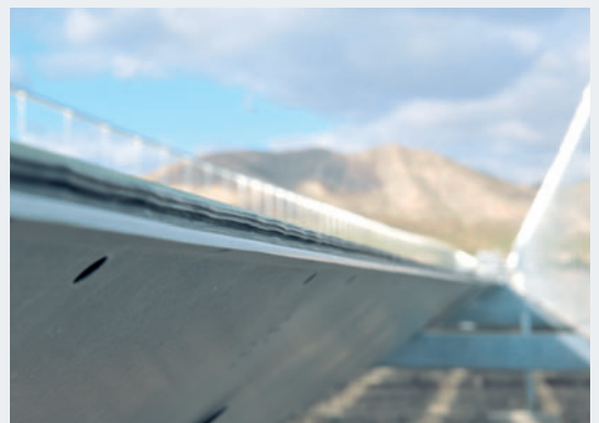
Trotz starker Sonneneinstrahlung hält der Terostat MS-Klebstoff die Spiegel auf den Stahlrahmen.
